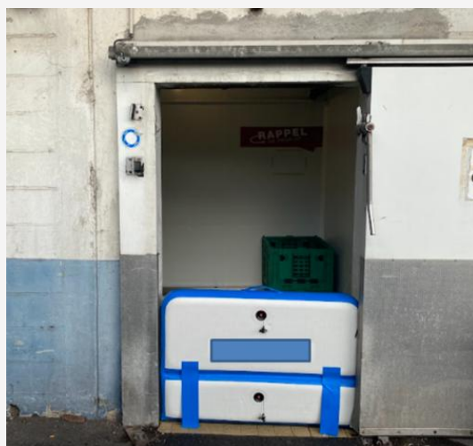
Mise en place de batardeaux amovibles pour la protection des ouvrants sensibles du site
