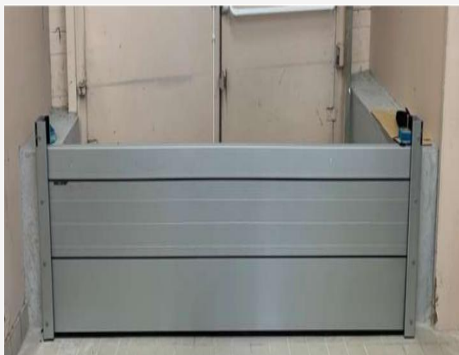
Mise en place de batardeaux amovibles pour la protection des ouvrants sensibles du site
