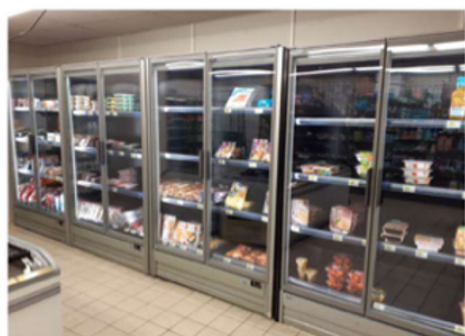
Vente et installation de 4 armoires positives autonomes reconditionnées
