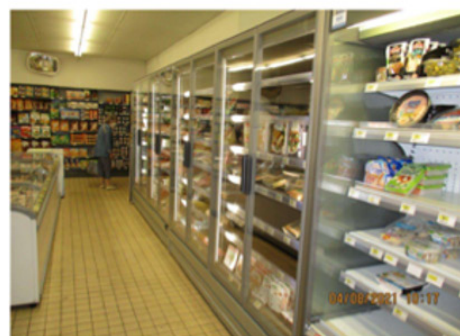
Vente et installation de 2 armoires positives autonomes reconditionnées
